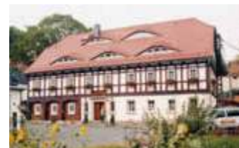
bindehaus, das allein schon als Bau- denkmals einen Besuch wert ist.
